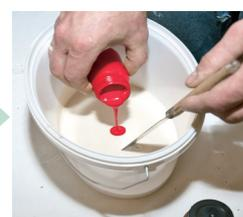
※ 凹凸部分などで隙間に塗料が入りにくい場合は、**水で10%希釈**する。(下塗りのみ)
