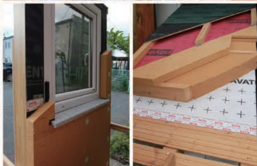
木質断熱材(スイス製)。施工はサネにより接合するため、断熱欠損を最小限に抑える構造。
