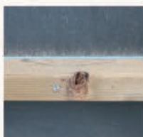
ビスを打ち込んでも水の浸入を防ぐ防水シール(ブルーの部分)。欧州にはこういった細かなところにも配慮した部材が揃う。
