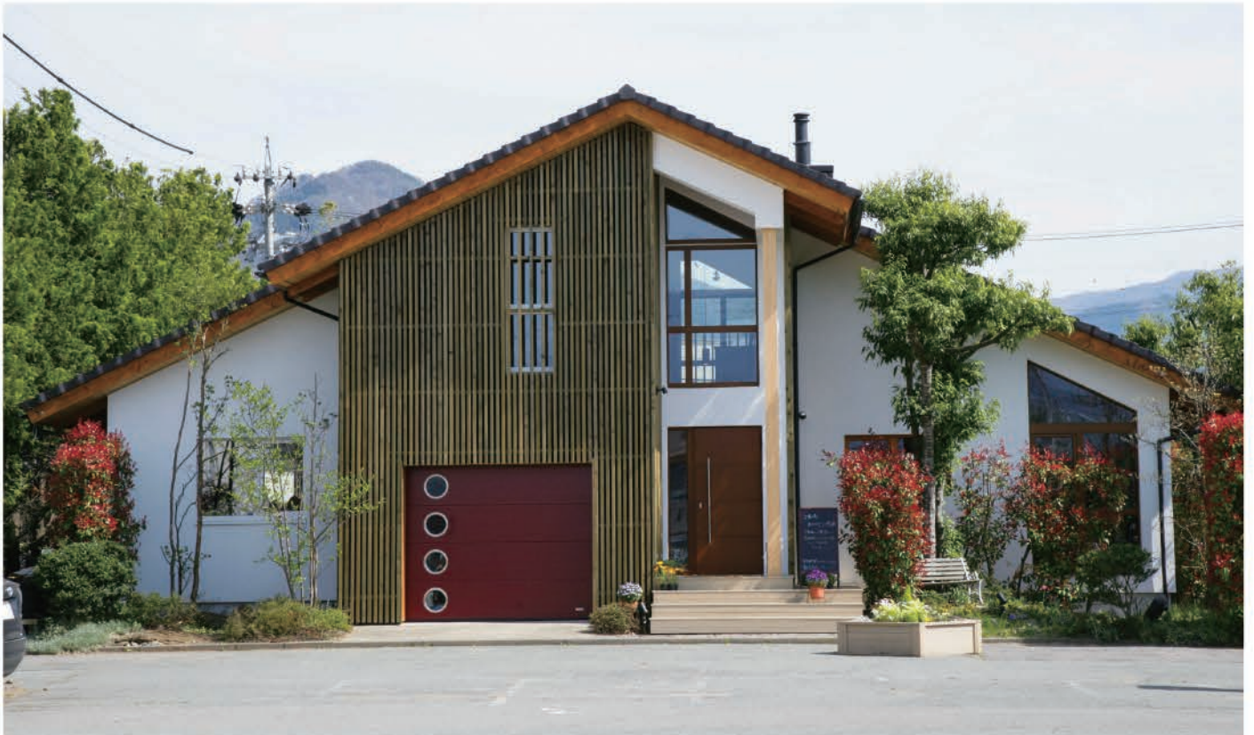
施工事例：(上)K'z HOME(愛知県半田市) 内・外壁：カルクウォール (下)株式会社ヴァルト(長野県長野市) 外壁：カルクファサード
