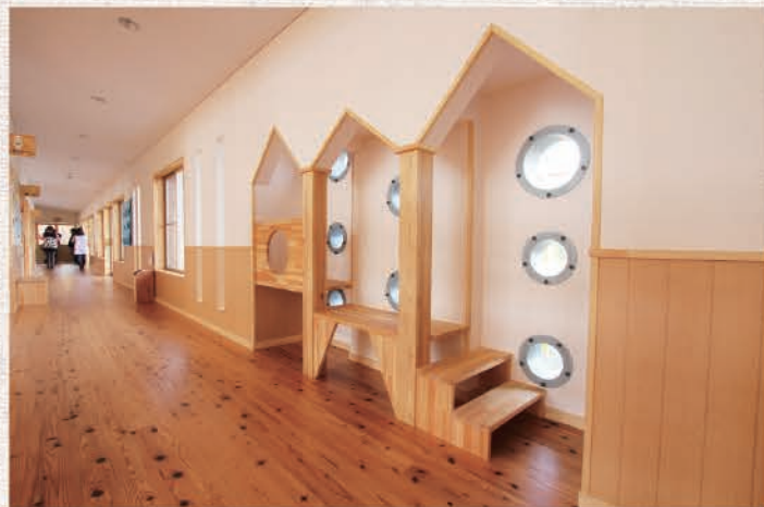
子ども達の手が届く所まで腰壁、壁面及び天井部にはオガファーザーNEWにリボス デュブロンを塗装しています。
