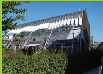
パッシブハウスの規格に適合した建物。南面には布製の帆が設置され太陽電池としての役割を担っている。帆状の幕は、採光の調整やウィンドウキャッチャーとして風を取り込むなど、季節に応じた暮らし方を提案する。
