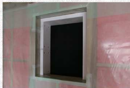
熱橋を考慮しサッシ廻りをEPSで断熱。窓は、外装・内装の工事を進めながら後付けする。
