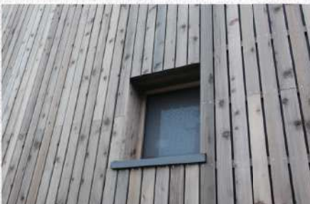
外壁は「秋田赤ナマハゲ杉板」をファサード・ラタンで縦張り。板と板との隙間を設ける事で空気を通し、外壁にかかる日射の影響を抑える。
