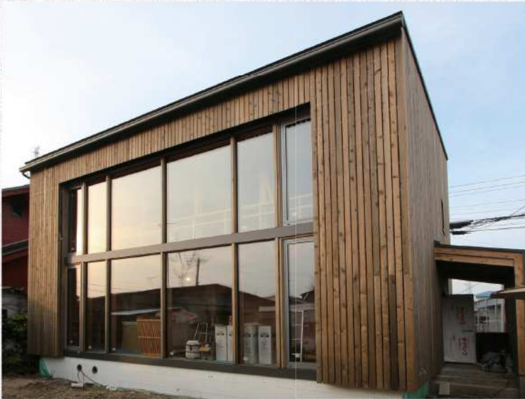
屋根は太陽光パネルを設置する片流れ。無駄を削ぎ落としたシンプルな外観だが、南面に設けた大開口が目を引く。
