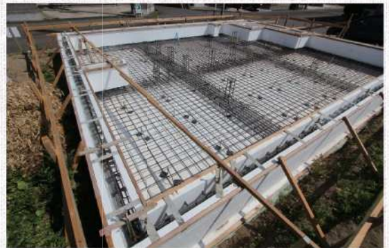
床下エアコンに対応した基礎断熱は、立ち上がり無くし大きな空間にすることで家全体を温めることができる。(基礎：防蟻ビーズ法ポリスチレンフォーム特号120mmスラブ下：同100mm全面敷込)
