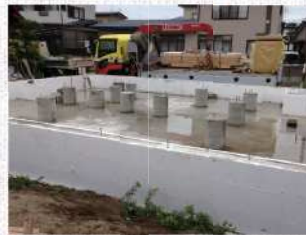
床下エアコンに対応した基礎断熱は、立ち上がり無くし大きな空間にすることで家全体を温めることができる。(基礎：防蟻ビーズ法ポリスチレンフォーム特号120mmスラブ下：同100mm全面敷込)
