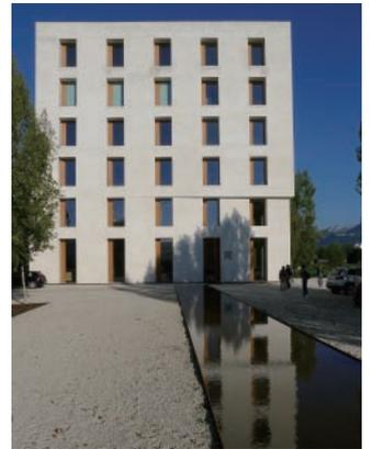
オフィスビル2226 館(オーストリア) 軽体の性能を高め、暖房、換気、冷房のシステムを排除したミニマムエネルギーを実現
