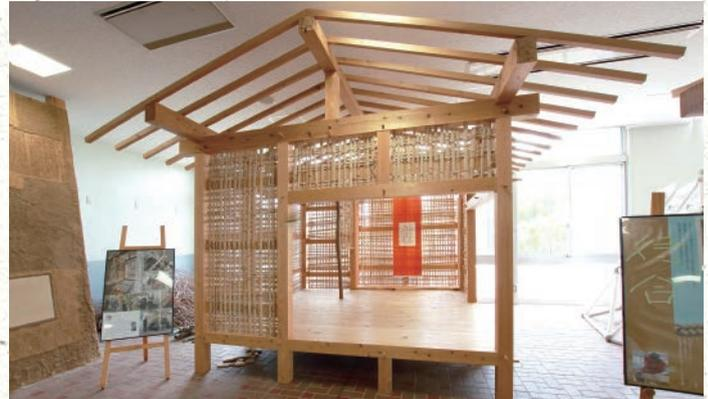
伝統的な継手・仕口をノミや鋸で刻み軸組をつくり、大学の竹藪で採った竹で竹木舞を編み上げています。
