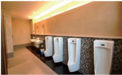
トイレ正面の壁は、大学キャンパスの土を使って仕上げた天津磨き。面台は、モロッコなどで用いられるタデラクトで仕上げている。
