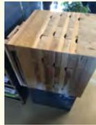
室内側の柱を並べて内装仕上げを兼ねた縦ログ部分は、耐力と防火を担っている。その裏に溝を掘った間柱を互い違いに並べて、空気を含んだ積層パネルを施工。さらにハードタイプの木繊維断熱材80mmで覆うことによって、隙間をなくし木材の断熱性を増強させている。接着剤を使わずに固定されたパネルは壁体内結露のリスクを減らし、調湿効果も高い。
