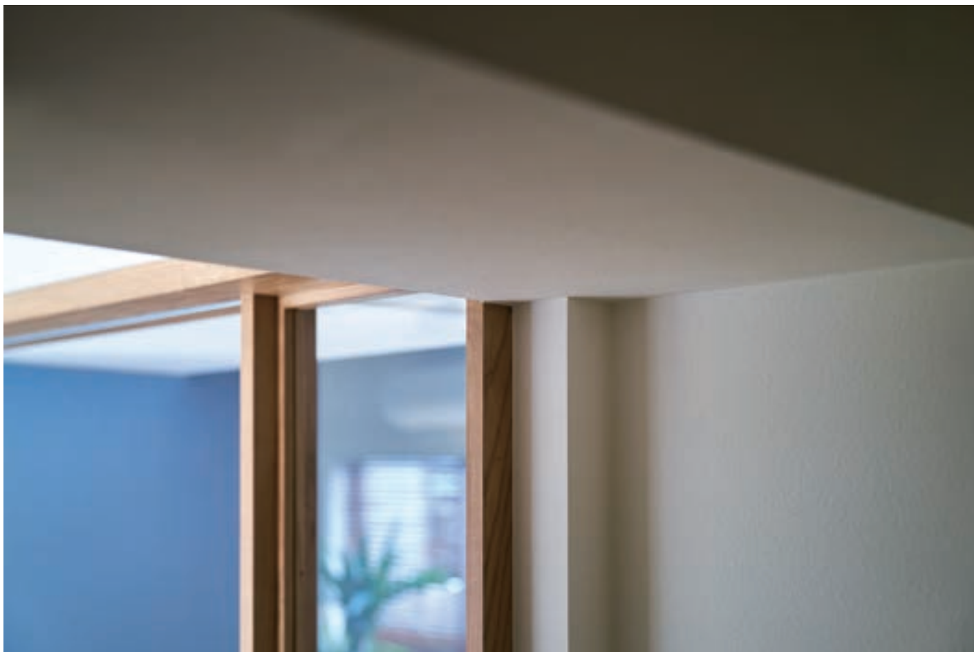
木製サッシとオガファーマーザー+デュブロンで仕上げた内装
