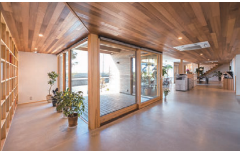
1Fの床は蓄熱性の高いモルタル仕上げ。 冬は日射を取り込み温められた土間床が室内をゆっくりと温めてくれる
