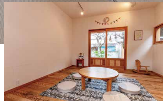
幼稚園の内装壁は、シュタイコベースの上からレームファルベ粘土塗料をDIYで塗装した
