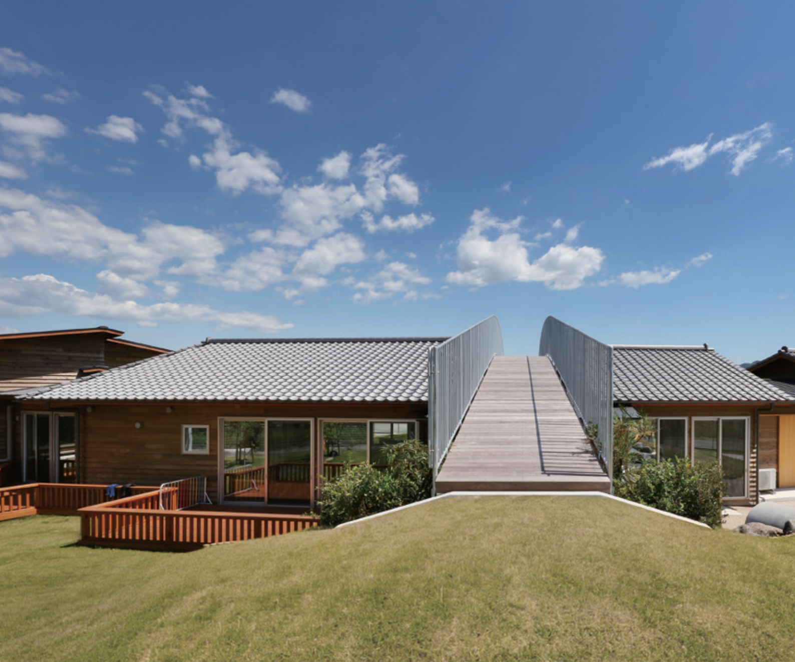
園庭の小高い丘から園舎を跨ぐように架けられた橋 どんぐりの森保育園
