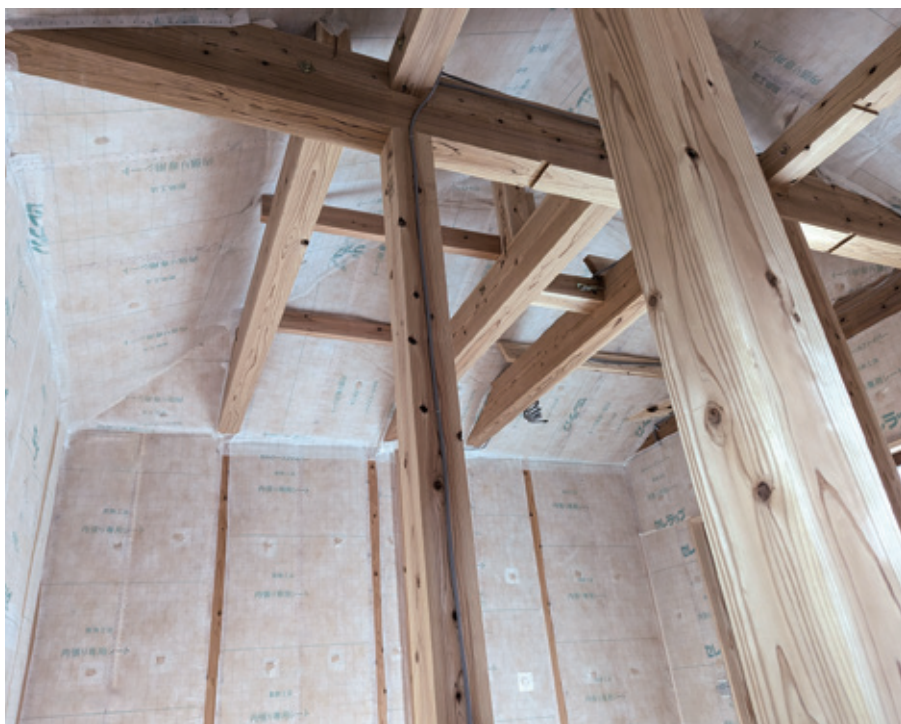
シュタイコゼルを吹き込んだ後は、調湿・吸音効果で室内環境がガラリと変わる
