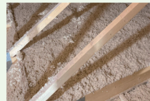
屋根の吹き込み又は天井の吹き積もらせ
