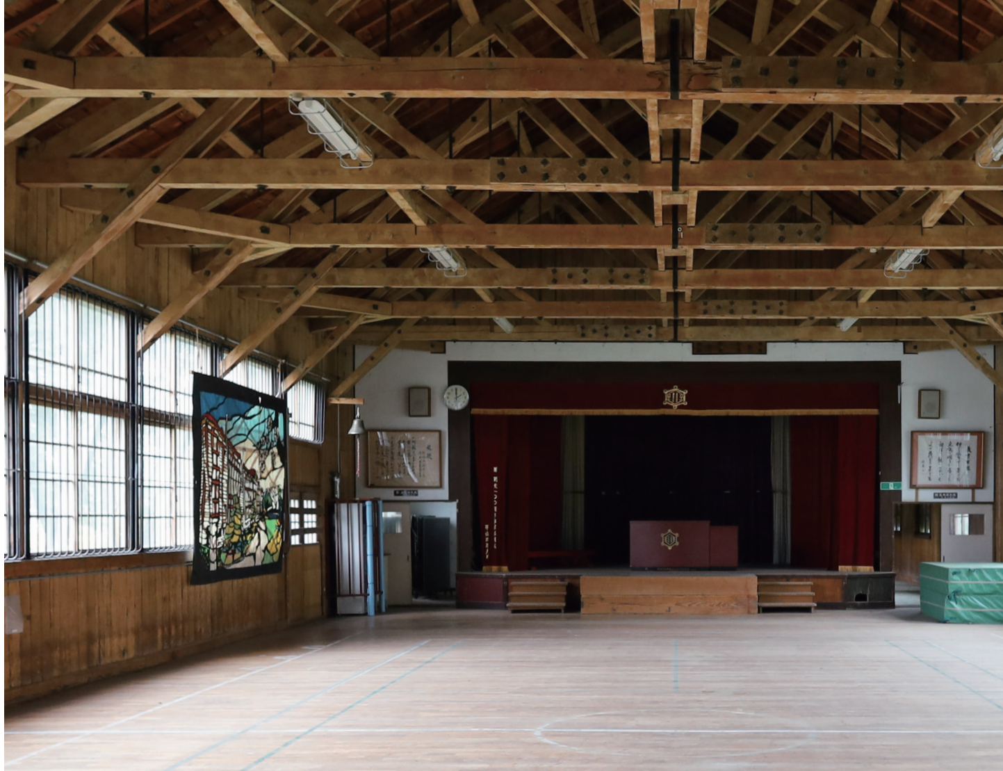
蒸溜所として活用される、改修前のメイン体育館。各所に経年劣化が見られるなか、可能な限り修繕を行いながら再生が進められた。
