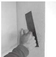
4. 下こすりしたカルクウォールが乾かないうちに、追っかけでカルクウォールを上塗りします。塗り厚は、骨材0.5mmタイプで2mm程度、骨材1.5mmタイプで4mm程度に塗ってください。また、コテで何度もこすると艶が出て、艶ムラになります。仕上げは一度でさっと塗り仕上げてください。
