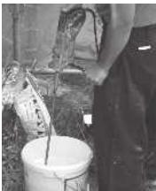
2. 水で練ったカルクファサードを15分程度寝かせ、攪拌ムラによるダマが出来ないようにします。
