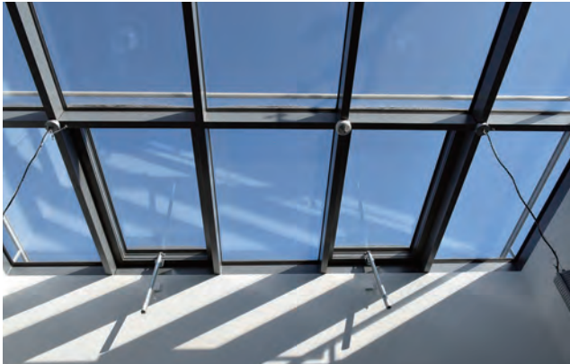
【写真中】室温を感知して自動的に開閉する天窗
