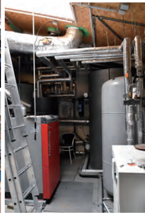
【写真下右】屋根裏に設置されたペレットボイラーと貯湯タンク
