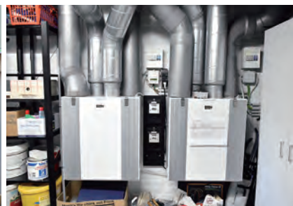
【写真左】歴史的な価値を次代に伝えようとリノベーションされた建物 【写真中】外壁として施工した断熱材の厚さを説明するルードリヒさん 【写真右】地下に設置された熱交換システム
