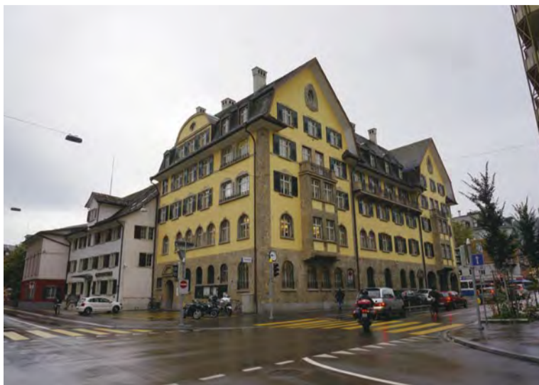
▲スイス・チューリッヒ市内で文化財保護の指定を受ける役所施設。2年前まで断熱改修を含むリノベーションが行われた。断熱効果と持続性の両面から天然の石灰岩からできた漆喰が使われた
