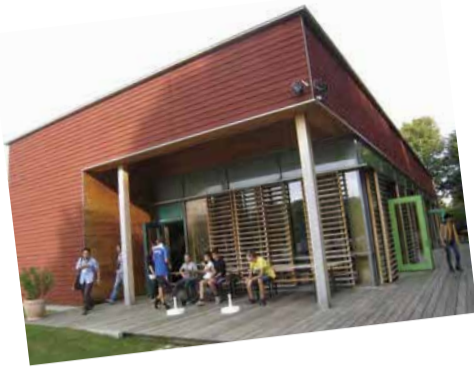
西側から全面ガラス張り、日射を遮るルーバー引戸を備えている。生徒は夏から冬にかけて、木製のルーバーを動かして、自然光をあびながら過ごす。
