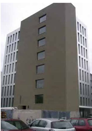
木造とRC造のハイブリッドによる8階建てオフィスビル「LCT ONE」の外観
