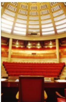
ペレは、自身の「君主の盾(sovèreign shield)」の論理を反映するためにこの様式(天井が柱によって支えられている部屋)を選びました。長さ60メートル、幅18メートルの、柱で支えられたホールは、建物の構造から独立していて、天井は配置された高さ20フィートに合わせて切断された6メートル間隔の溝付き柱によって支えられています。天井には、装飾効果を提供し、騒音を抑えるために設計されたコンクリートの梁が木材パネル(ライムオーク)に挿入されたボックスを形成しているのが見られます。
