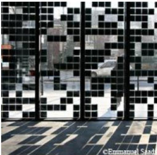
発電のほかに、ガラスのファサードに含まれている電池は日よけの役目を果たし、光の流れ、外の景色、プライバシーの調整の働きをします。ガラスフレーム内への電池の配置は、既存の石工ミルストーンの写真をピクセル化した結果を基に行われます。ガラスの中に組み込まれた光電池と、その反射が光と戯れて、現代のステンドグラス・ファサードに変わる美的特質は、既存の建物と新しいファサードの間の関係性の方向付けに強く関与します。
