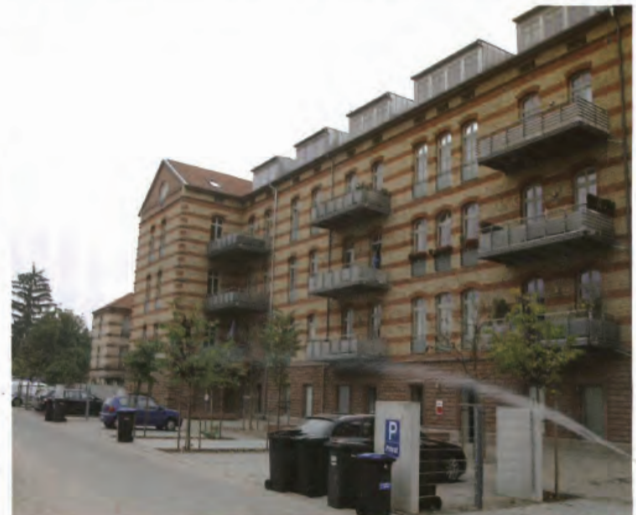
シュパイアーの再開発プロジェクト。オジカ社がこの兵舎のリノベーションを請け負った。歴史的な文化財であるため外観はバルコニーをつけたほかは120年前とほぼ変わっていない (*写真: AFD設計工房・大友綾子氏)
