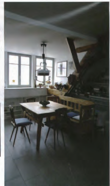
この改修物件を購入し、ひとり暮らしをする70代の女性・ホルツさんの住宅。屋根裏階のため、天井の高低差(一番高い所で3400mm)補強柱をあえて効果的に使った設計がなされている。丸窓は既存外観を維持するため特注。この日の室温は20度
