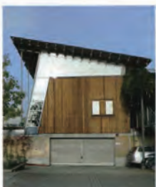
給排水や衛生日会なども兼ねる住民共有のコミュニティハウス。高窓の開口により夏は室温が40度にも上昇する。屋根断熱層には、地域の子どもが回収したワインのボトルを500万個分を砕いて再利用している
