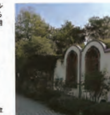
エコステーション特設、自然性を高める壁土・緑化屋根に、一部断熱材からのリユース材をつかっている
