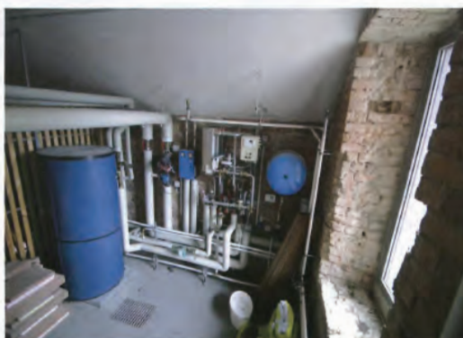
中央棟地下には、再生可能エネルギー(ゴミ処理熱など)で水を温め暖房に利用する局所装置を設置している (*同)
