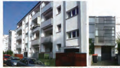
グロビウス設計によるダンマーシュトックの集合住宅。10～20年前にポリスチレン断熱材によって断熱改修した。当時は1戸あたり45・00・70㎡の3種が用意されたが、リノベーションにより現在は変更されている個所もある
