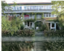
南面は開口部が広く、すべての居間にソーラーパネルを装備。夏は室温が40度にも上昇する。屋根断熱層には、地域の子どもが回収したワインのボトルを500万個分を砕いて再利用している
