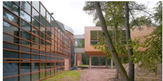
北側(ピロティーの上に会議室がある)
