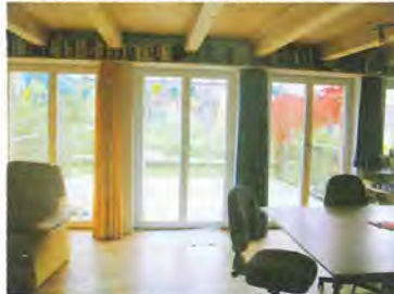
シュナイダーさんの部屋のリビング。ガラス窓はU値=0.7W/m2K、紫外線透過率1.1%の高性能をもつ。窓枠は無垢材を白塗装したものの
