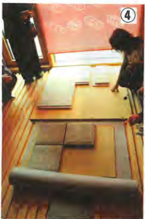
④ 床仕上げ。マッシブホルツの躯体床に羊毛や木質繊維製の断熱マットを敷く。仕上げの素材もさまざまに選べる
