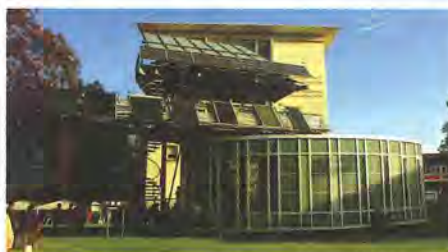
フライブルク市内の「リヒャルト・フェーレンバッハ実科学校」の校舎前に建てられた太陽光発電を学ぶための学習施設。同校では太陽光発電習得コースを設置している
