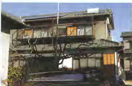
一見、開口が大きそうな古い家だが、東西北の開口が抑えてあるため、開口面積率は20%にとどまる
