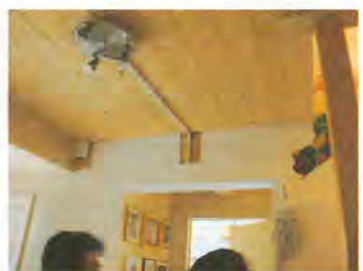
団地住人のシュナイダーさんの部屋の階段ホール。石灰砂岩をコンクリートで固めたブロック壁と、無垢の天井梁を重ねる混構造
