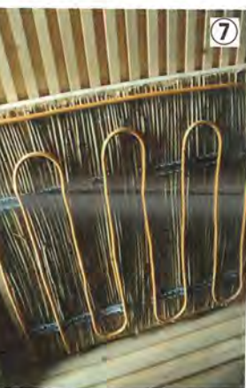
⑦ 壁暖房の施工例。木板土台の裏には乾燥した植物の茎が敷き詰められていた
