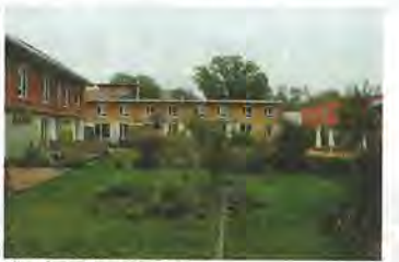
敷地南側の中庭付き集合住宅群。テラスがコの字型で125㎡の広い中庭を囲む。130㎡の床面積をとり、住者が集いやすい間取りを実現した
