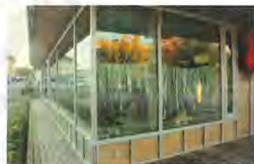
外装蓄熱システム「ルシード」を外壁全週に施工した「パラディスリ幼稚園 (Kindergarten Paradiesli) (スイス・ヴィル市)
