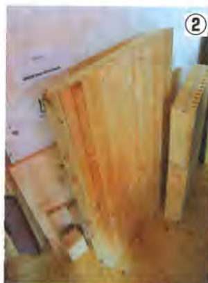
厚い無垢板を木ダボで重ねて構造躯体としたマッシブホルツの壁パネル
